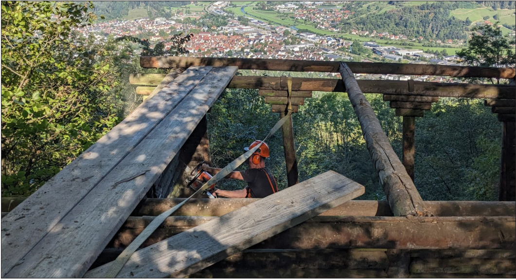
Die Bauarbeiten für die neue Sandhaasenhütte sind in vollem Gange.
